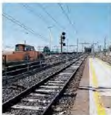
La stazione di Bicocca. Sarà ristrutturata
